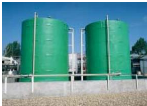
A kármentesítő medence kapacitása 110% legyen a legnagyobb tároló tartály kapacitásának
