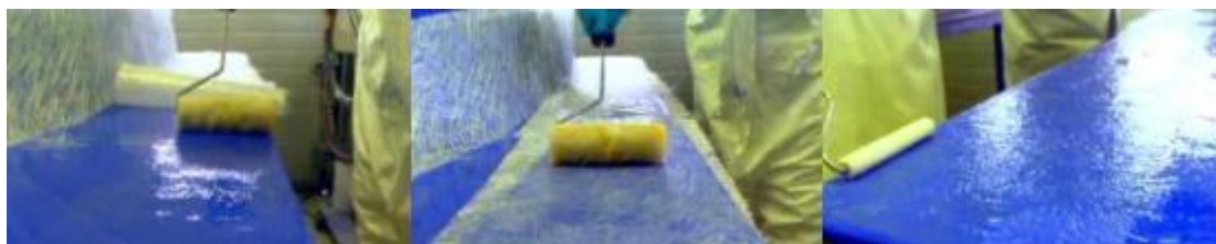
3. ábra Csatolóréteg felvitele
