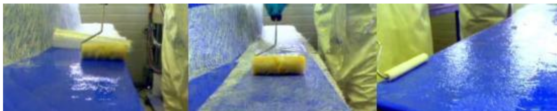
5. ábra Csatolóréteg felvitele
